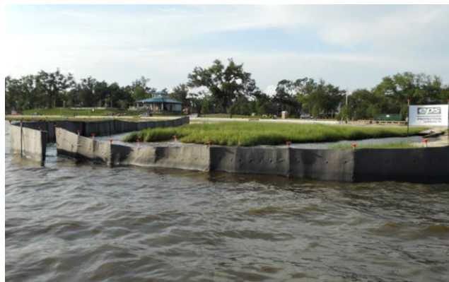
Alabama, marsk område, april 2010. Væg af hydrofil geotekstil. Foto: Ultratech International Inc.
